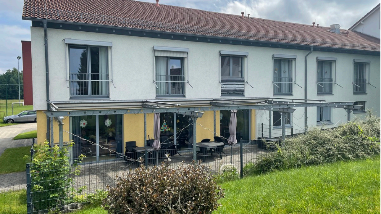
SZ WDK Ansicht unterer Gebäudeteil
