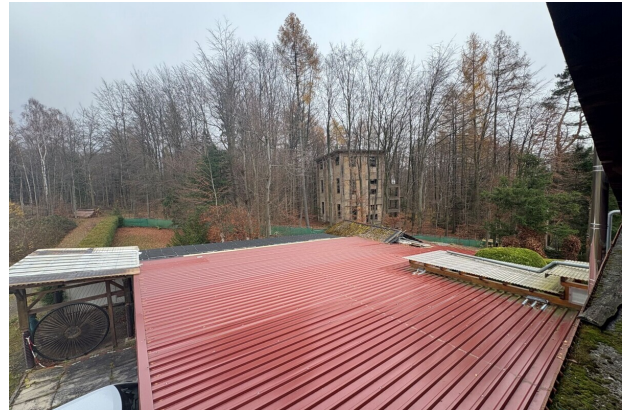
neues Trapezblech über Garagen und Eingang
